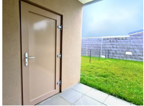
Abstellraum auf Terrasse
